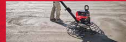
SCHRITT 3 GLÄTTEN & FERTIGSTELLEN
